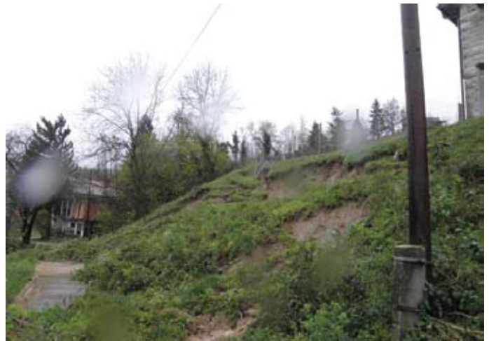
Nova klizišta u Radobojskom Orehovcu i Jazvinama nastala uslijed velike količine oborina.
